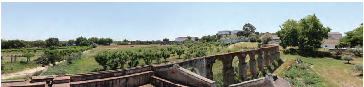
imagem 36) Troço do aqueduto no interior da quinta
