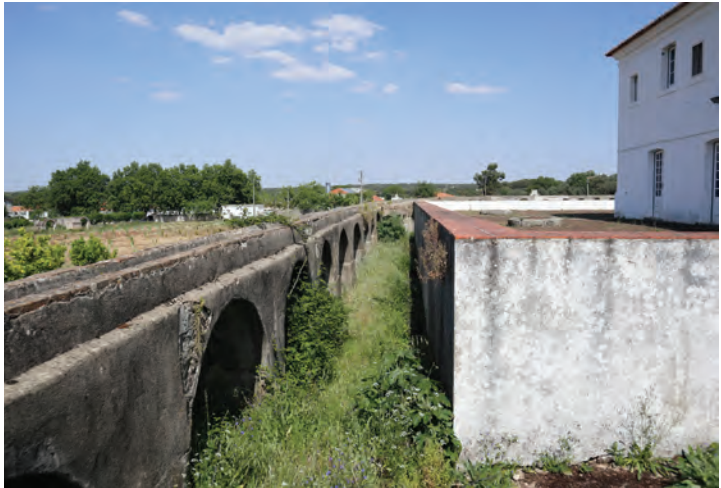
imagem 34) Aqueduto e tardoz do Conventinho
