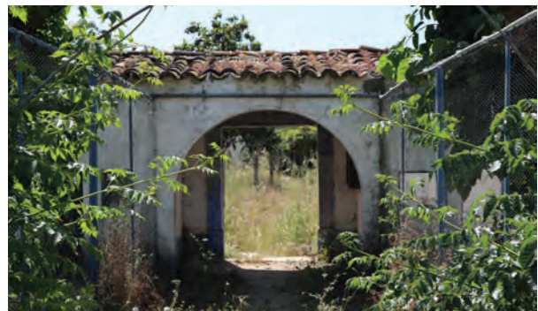
imagem 10) Construção em torno do Tanque dos Laboratórios
