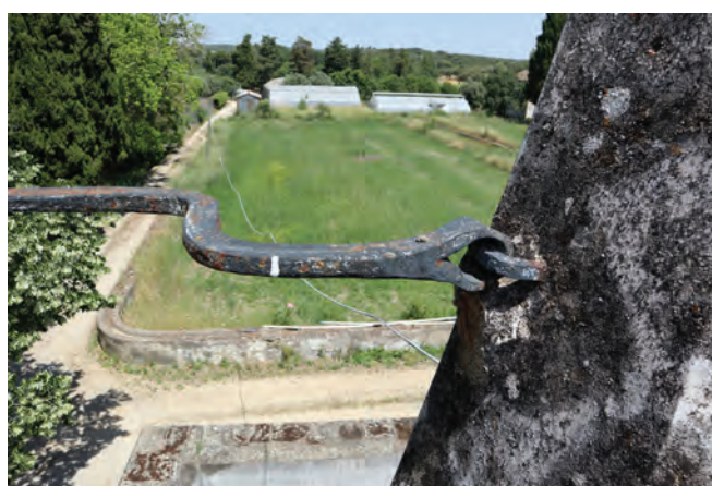
Imagem 11 - Ferro forjado como guarda no terraço da Casa da Água
