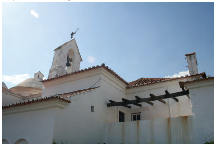
imagem 13) Vista da cobertura
