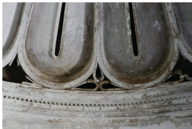
Imagem 4 - Trabalho de estuque na cúpula da Capela das Penhas
