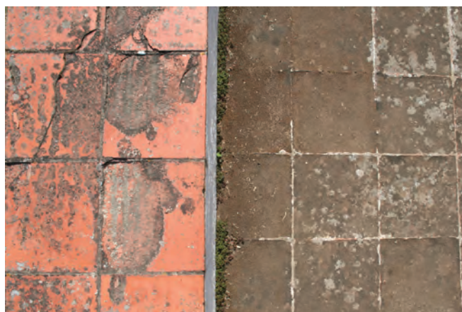
Imagem 8 - Pavimento e muro revestido no exterior do Conventinho
