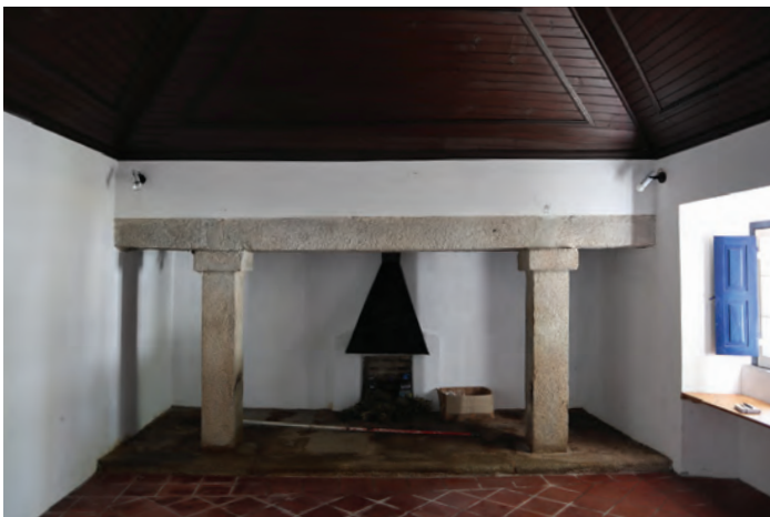
imagem 28) Lareira; Casa dos trabalhadores rurais
