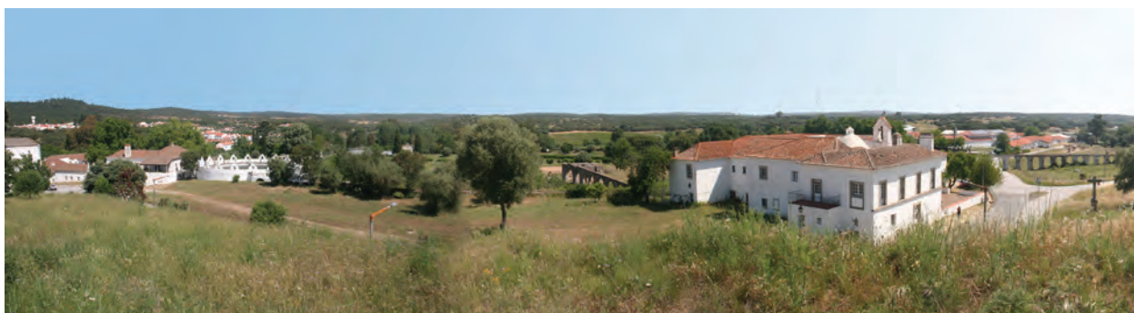
imagem 11) Panorâmica da via de acesso principal
