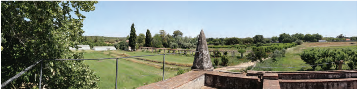
imagem 6) Vista da cobertura da Casa da Água
