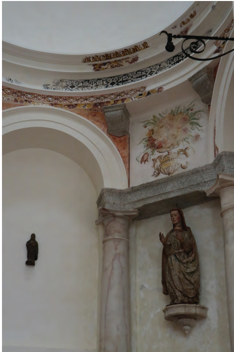
imagem 17) Pormenor de pintura; Capela
