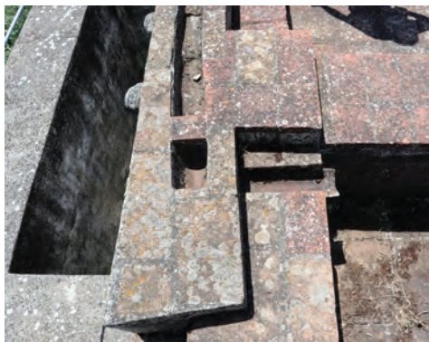
imagem 33) Pormenor caleiras; Casa da Água
