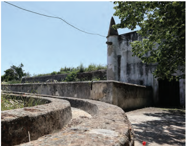
imagem 35) Muro cisterna e Casa da Água
